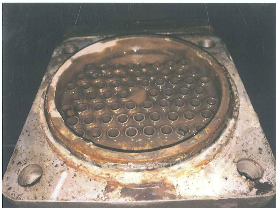
图 19: 3号机 2号冷却器管道完全无污垢, 用手擦去表面软泥状物质可见金属色
