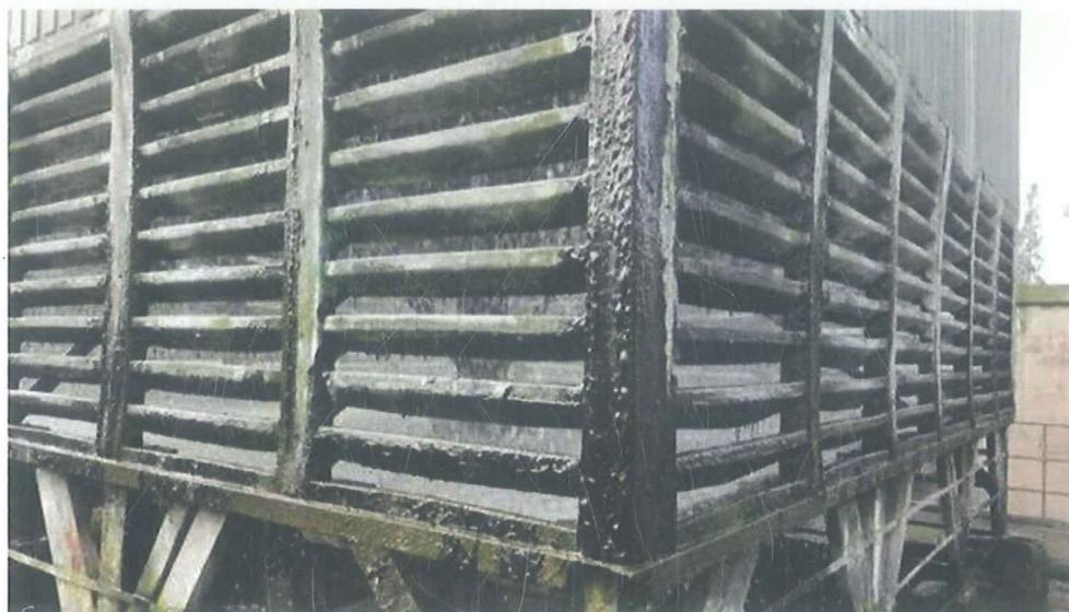
图 9：安装一周后（8月9日）冷却塔外部蓝藻已经大量死亡
