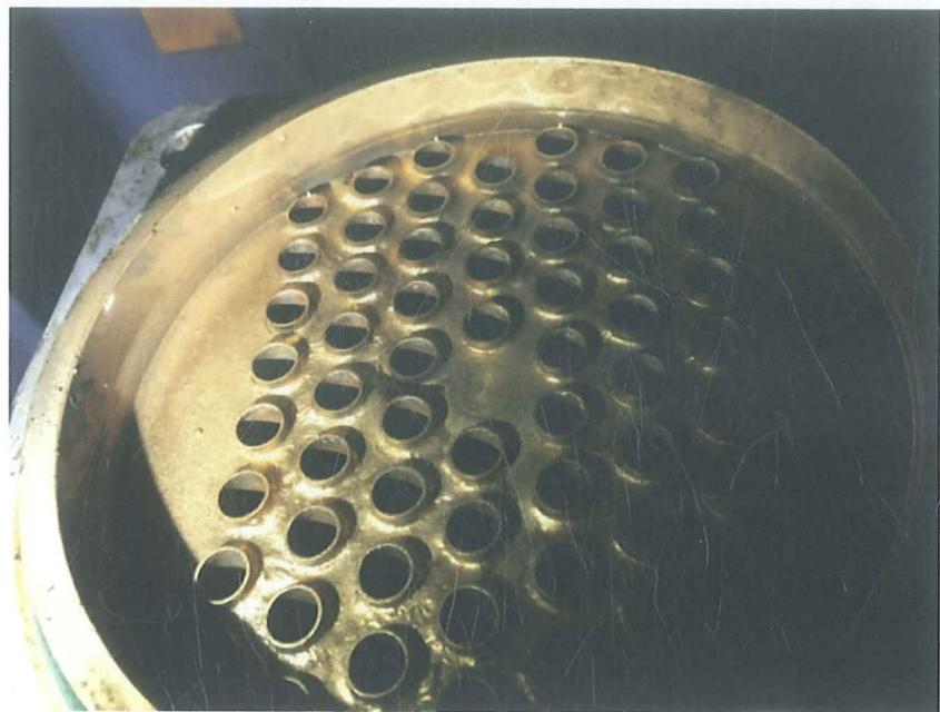
图 22: 5号机 2号冷却器表面无污垢, 连续运行 4 个月后, 保持了清洁
