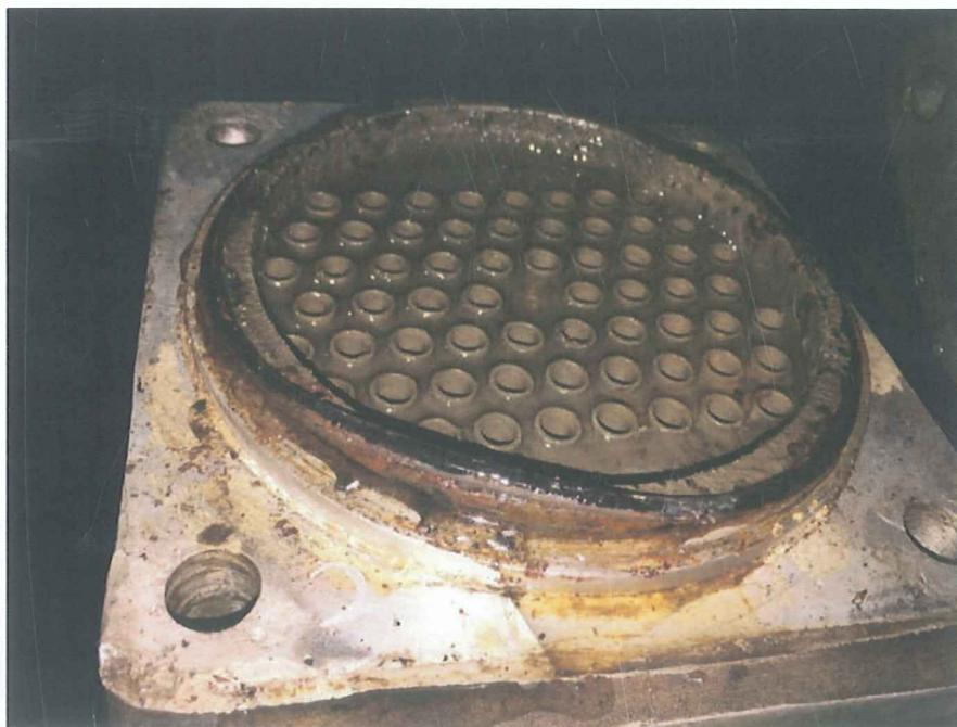
图 17：3号机 3号冷却器管道完全无垢，表面的软泥状物用手即可擦去
