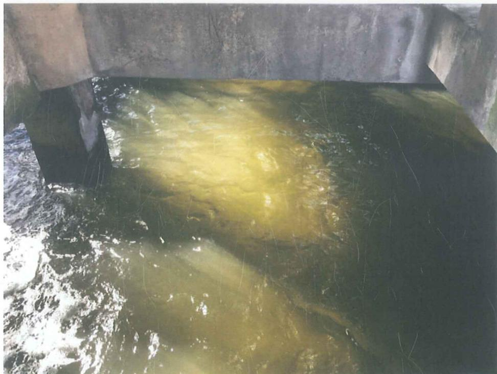
图 7：2月 14 日冷却塔底部水槽图片(水体逐步变清澈，颜色不再明显发绿，在阳光照射下已可见到底部)
