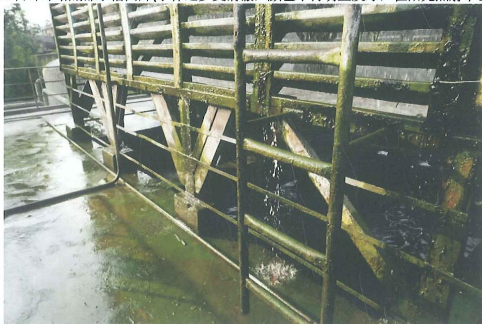
图 8：8月 2 日冷却塔外部有大量的蓝藻附着
