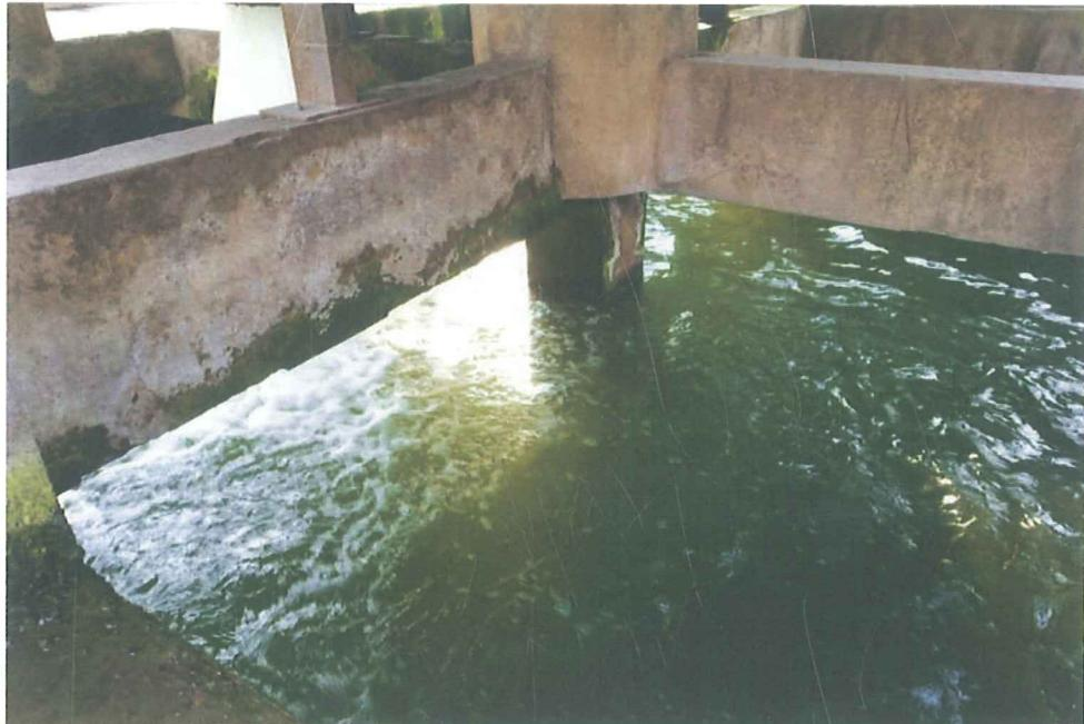
图6：8月2日冷却塔水槽底部图片，含有大量藻类，水体呈绿色
