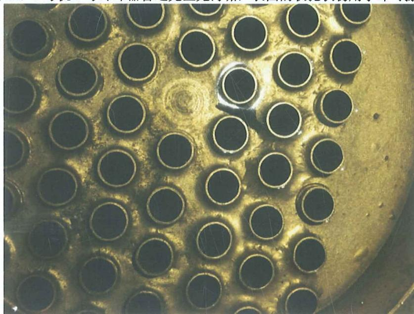
图 21: 5 号机 2 号冷却器管道完全无污垢, 连续运行 4 个月后, 保持了清洁的状态
